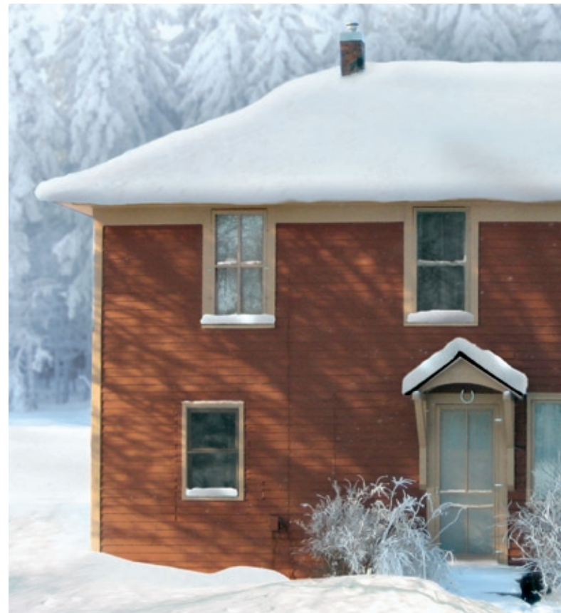
Gut gedämmtes Dach. Der Schnee schmilzt nicht, da die Wärmeabgabe gering ist.
