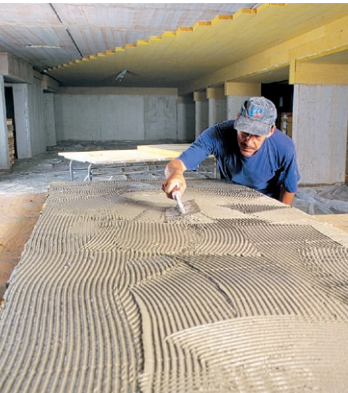
Kellerdeckendämmung von unten, Quelle: Deutsche Rockwool Mineralwoll GmbH & Co. OHG
