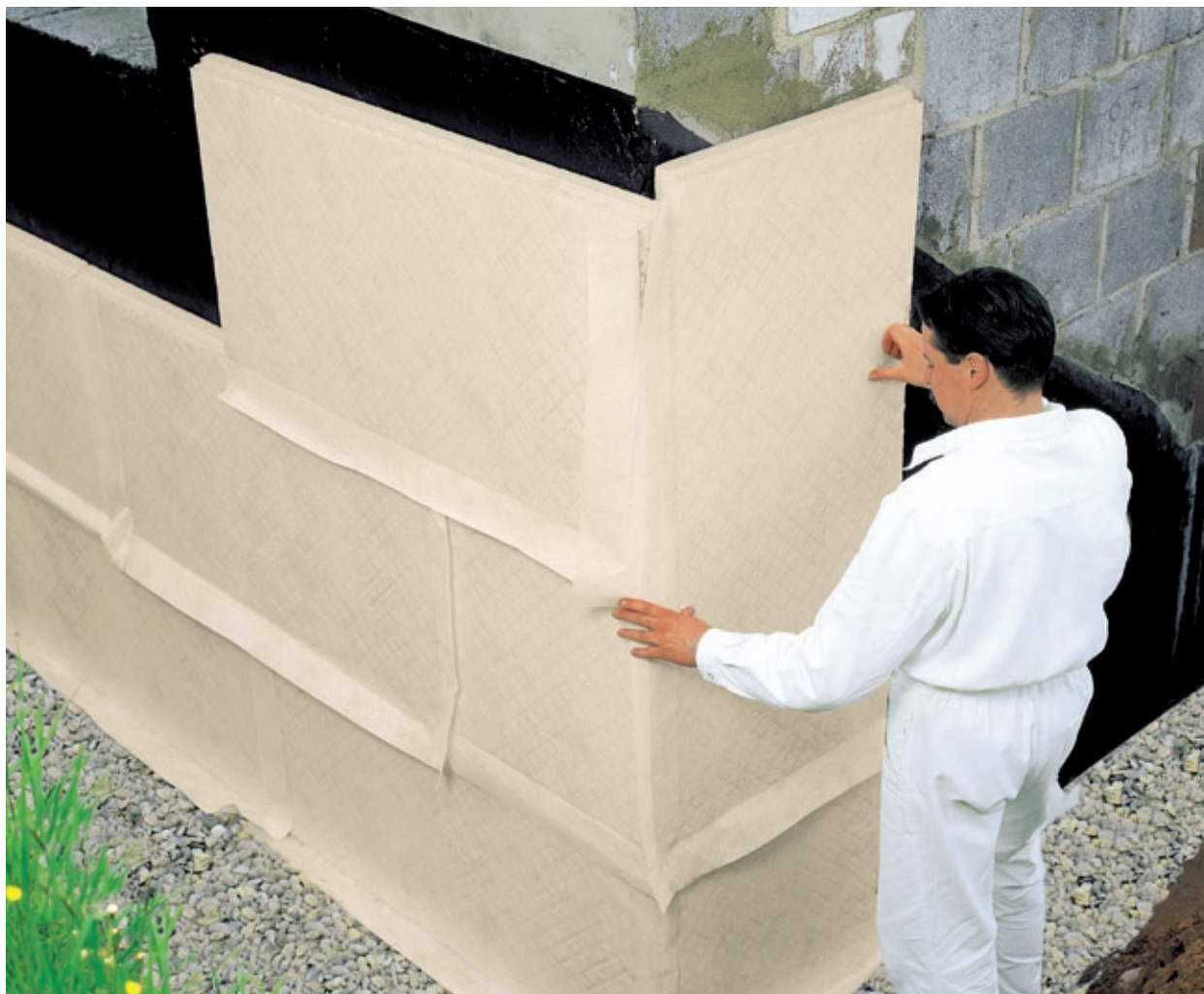
Perimeterdämmung der Kellerwände, Quelle: Rigips GmbH
