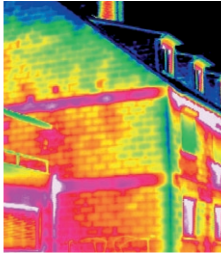
2. Haus vor der Modernisierung
