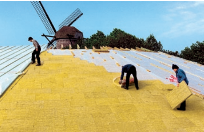
Aufsparrendämmung, Quelle: Deutsche Rockwool Mineralwoll GmbH & Co. OHG
