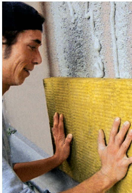
Wärmedämmverbundsystem, Quelle: Deutsche Rockwool Mineralwoll GmbH & Co. OHG
