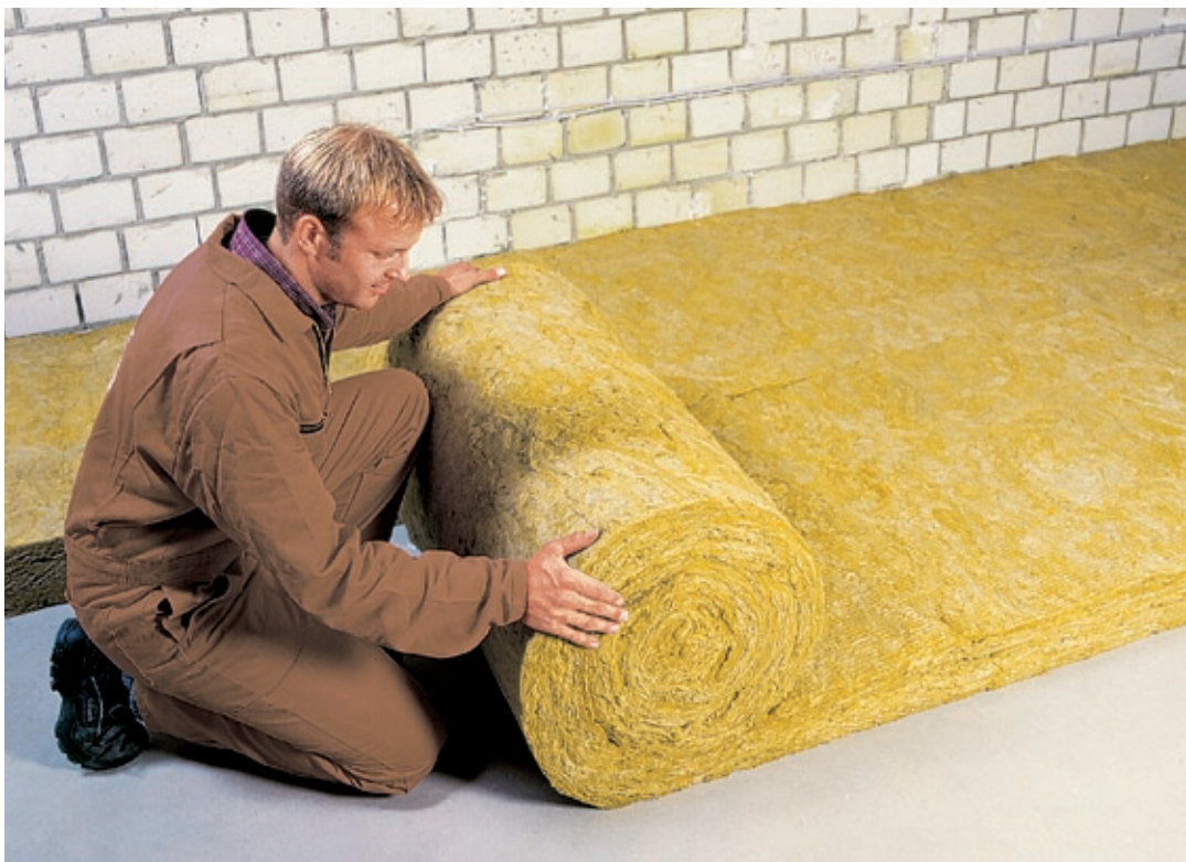
Dämmung der obersten Geschossdecke, Quelle: Deutsche Rockwool Mineralwoll GmbH & Co. OHG
