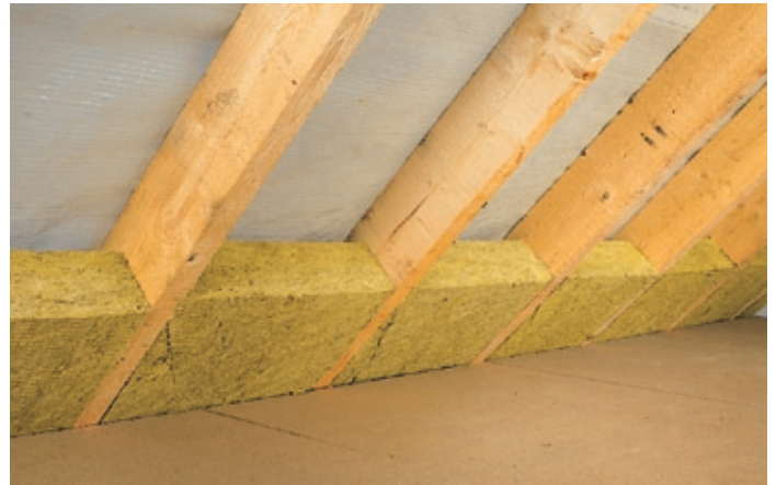
Zwischensparrendämmung, Quelle: Deutsche Rockwool Mineralwoll GmbH & Co. OHG
