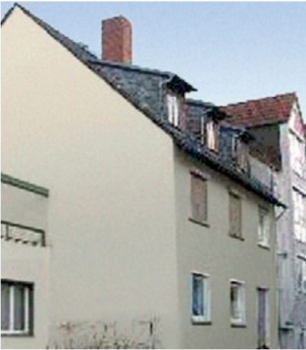
1. Haus, von dem eine Thermografieaufnahme erstellt wird
